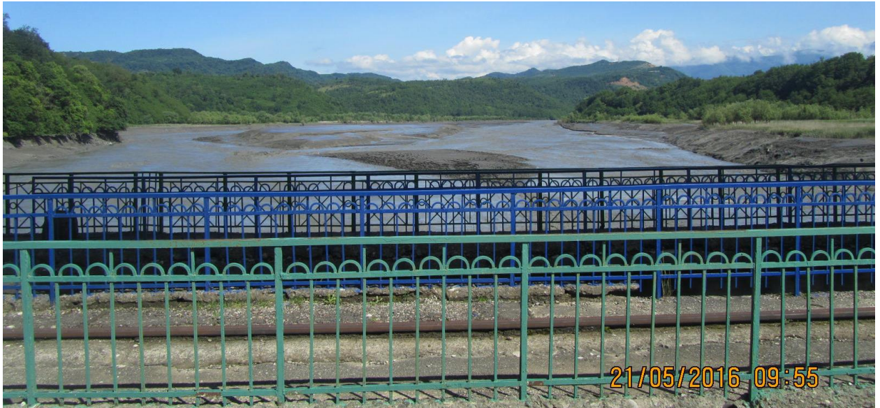
ნახ. 3. მდინარე რიონის გუმათიძეს I გარეცხვის პირველი დღე. კაშხლის ზედა ბიუფი მოლამული პირველი და მეორე კუნძული
